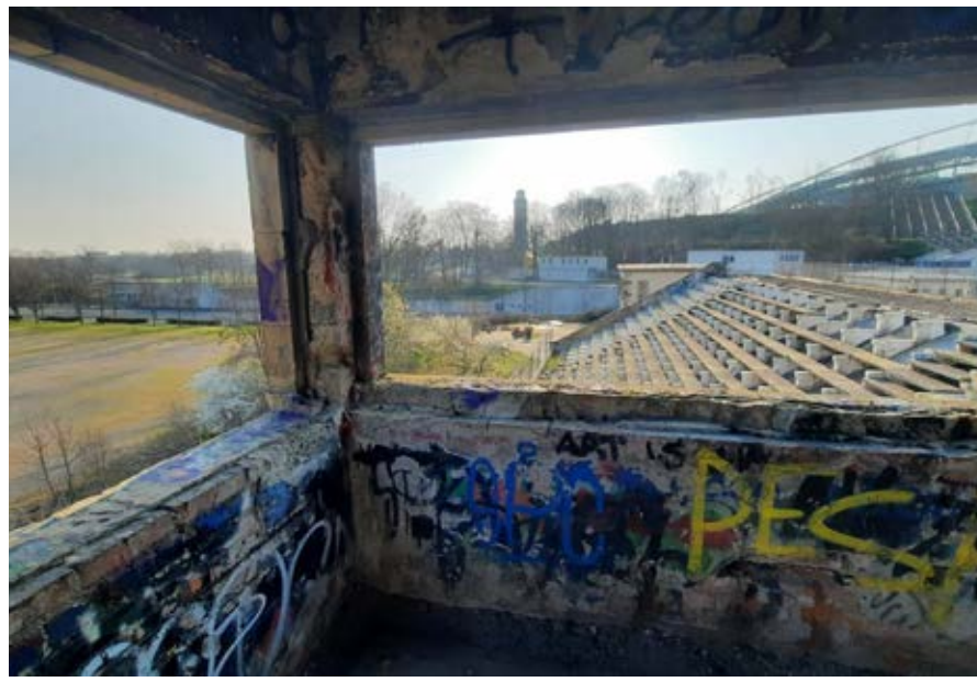
Blick aus dem Kassenflügel des alten Schwimmstadions auf die Nordtribüne
