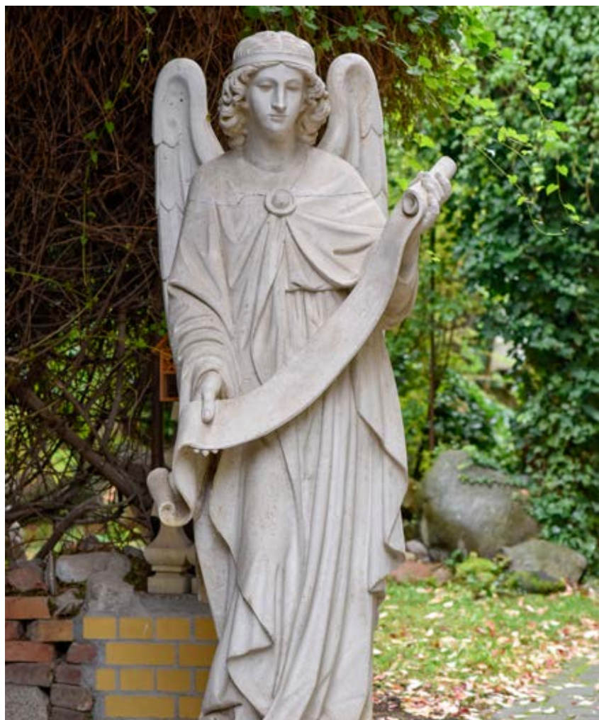
Engel vom Westgiebel der Leipziger Peterskirche, Gipsabguss, Original: 1885. Der originale Engel aus rheinischem Tuff drohte wegen starker Verwitterung abzustürzen und wurde 1994 als Steinguss rekonstruiert. Foto: Markus Scholz
